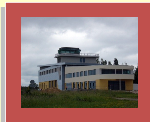
Les très belles installations de Chambley-Bussières
